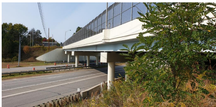
Fig. (1). The MAH-680-0283 bridge.
