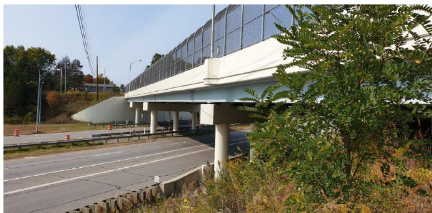
Fig. (1). The MAH-680-0283 bridge.
